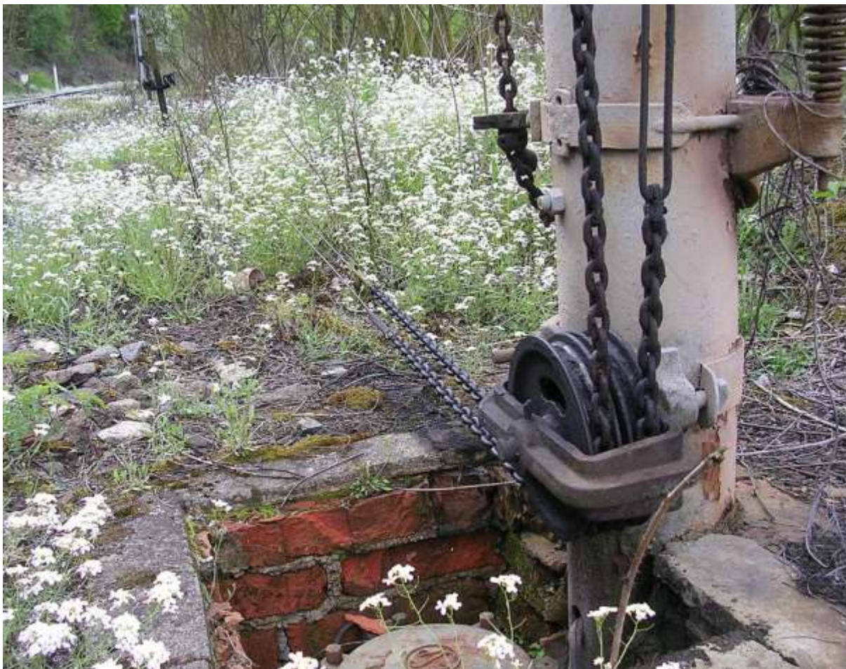
Provedení napojení drátovodů k trubkovému stožáru návěstidla v reálné situaci v terénu
